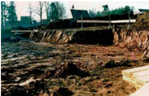
Baubeginn vor 30 Jahren im März 1995.
